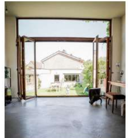
Grote hoge pui waarmee de binnen en buitenruimte ruim in elkaar overlopen. Ook de bovenlichten geven de diepere vertrekken extra licht.
