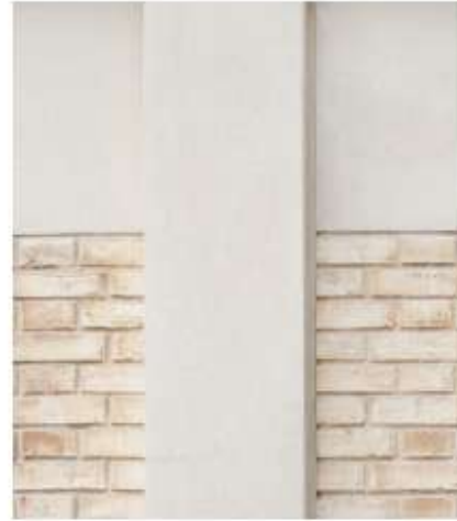
Granulaat beton, hergebruik van de bestaande Bonnemastructuren
