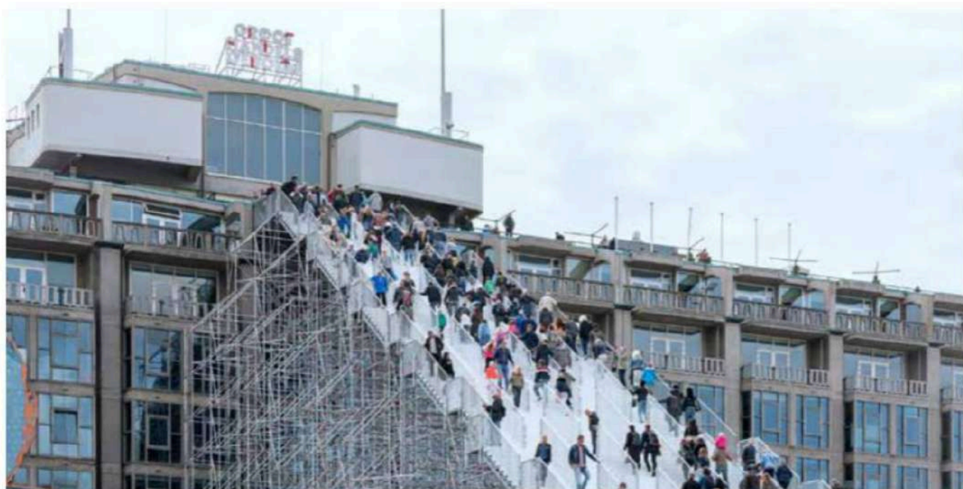
Deze thermisch verzinkte steigerinstallatie, De Trap, naar een idee van architectenbureau MVRDV is een knipooeg naar 75 jaar wederopbouw van de stad Rotterdam. (Beeld: Ossip van Duivenbode)
