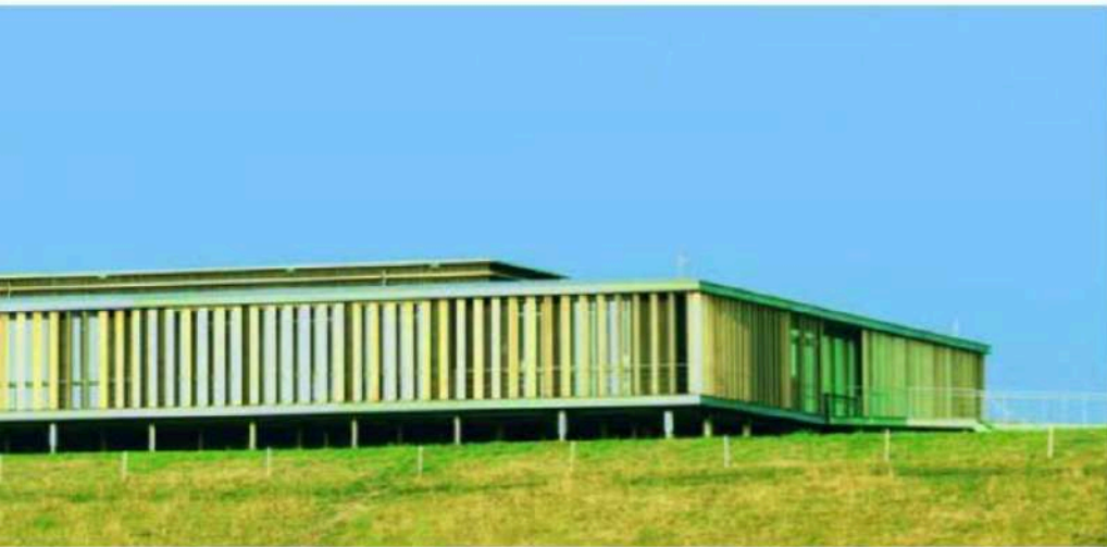
Circulair Paviljoen Energie Kenniscentrum, een licht gebouw dat met een nastelbare fundering op een voormalige afvalberging is gebouwd.
